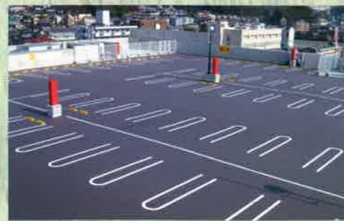
スーパー屋上駐車場(黒色塗装)照り返し熱防止
