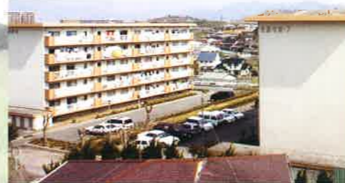
集合住宅外壁トップコート(福岡県) 室温低下・結露対策
