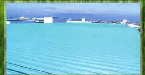
折板屋根(群馬県) 室温低下対策
